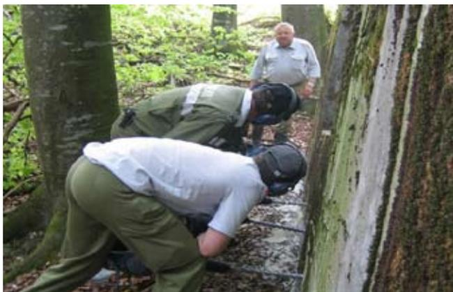
Nach den Plänen von OBR Ing. Hörschläger wurden von den Sprengbefugten die erforderlichen Bohrlöcher gebohrt. Unser Bezirks-Feuerwehrkommandant überwachte die Bohrarbeiten.
